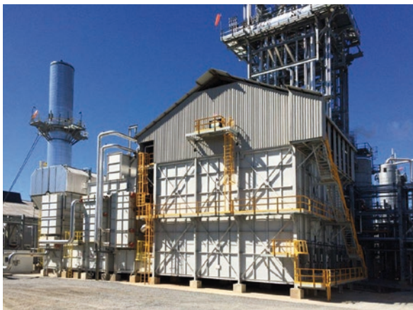
엘도라도시, 아칸소주에 위치한 엘도라도 화학 공장; LSB Industries의 일부
