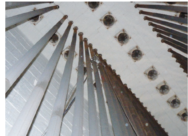
Pruebas de tubos reformadores con LEO-Scan
