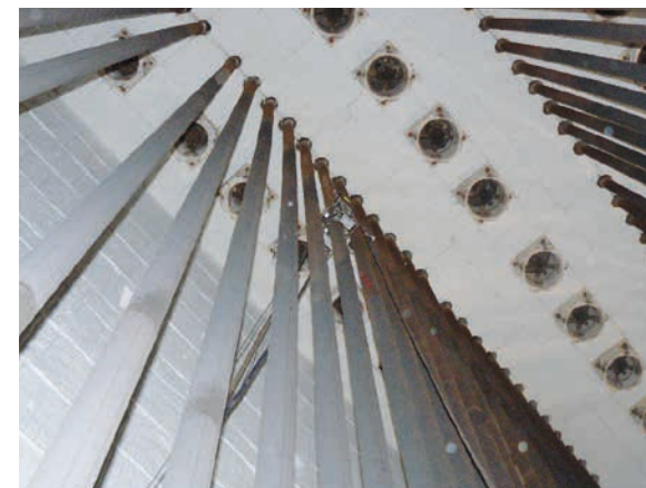
Испытание труб риформера методом LEO Scan
